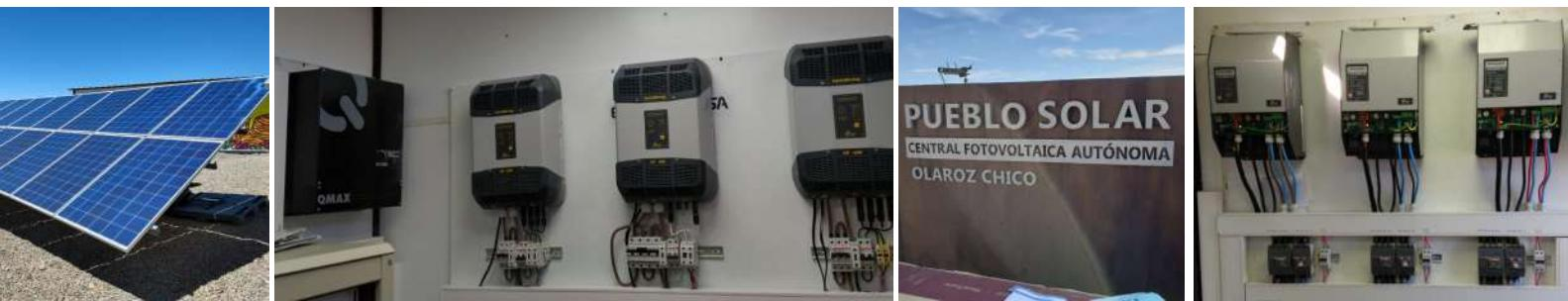
Para la generación de energía, se cuenta ahora, con un parque solar con paneles de 275Wp. Estos entregan una energía que luego es regulada para realizar la carga de los bancos de batería por 3 reguladores MPPT STUDER modelo VarioString VS-120.
